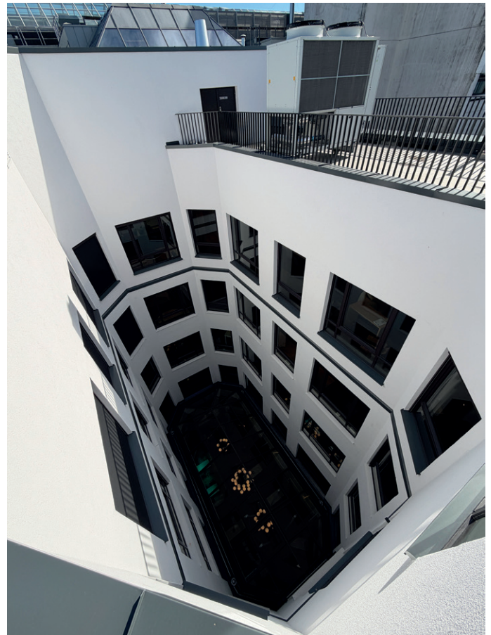
Det er bygget et nytt glasstak mellom plan 2 og 3.
